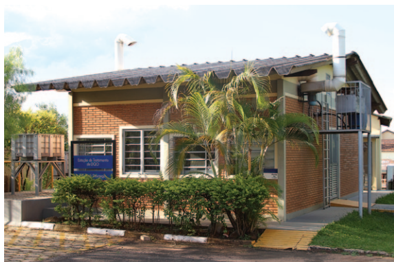
Figura 01 - Vista externa da LRQ
