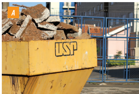
Figura 02 - A. Caçamba para coleta de RCC; B. Descarte irregular na Área 2 da USP - São Carlos
