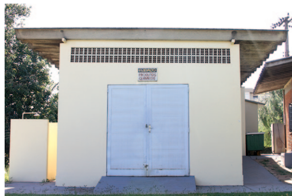
Figura 02 - Vista externa do Entrepasto de Armazenamento
