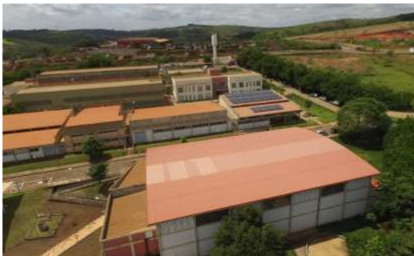
Figura 4. Instalação da usina de energia fotovoltaica no telhado do prédio dos laboratórios do IFMG Campus Congonhas.
