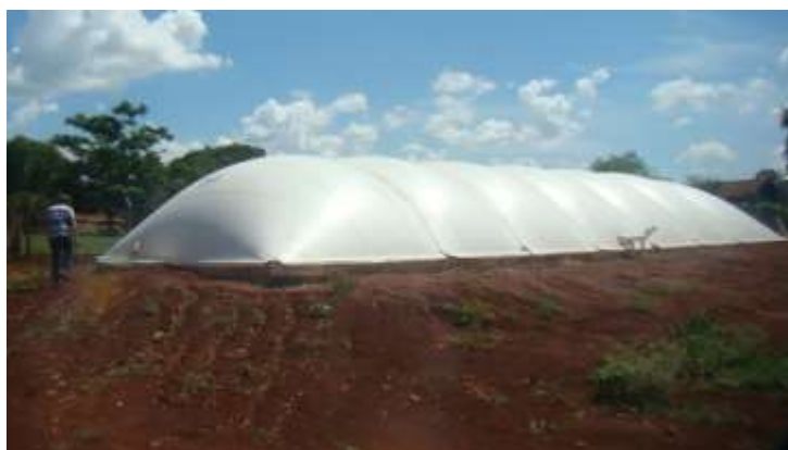
Figura 1. Biodigestor dos efluentes do setor de suinocultura da PUSP-FC no Campus USP Fernando Costa (Junho de 2018 - Foto de Rodrigo Mangetti)
