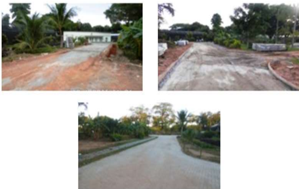
Figura 9 - Etapas de construção da Pavimentação Drenante
