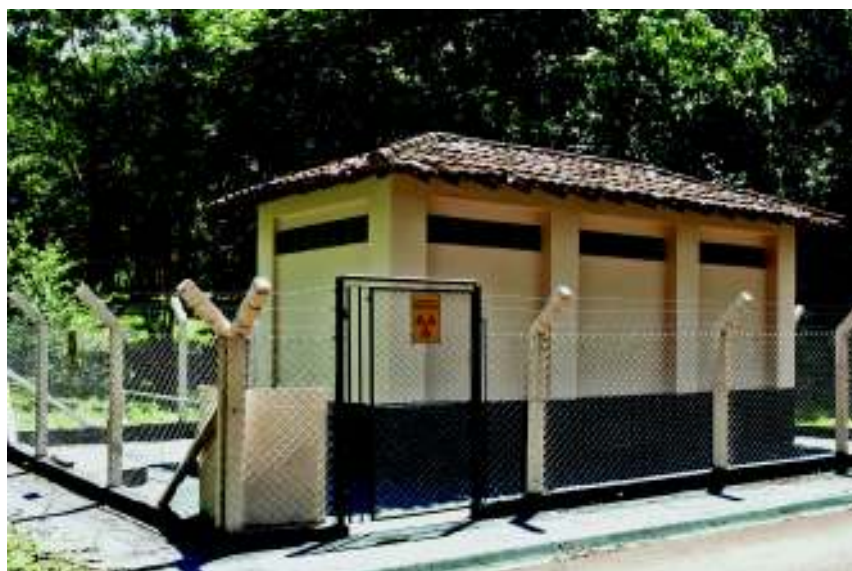
Depósito Provisório de Rejeitos Radioativos USP Ribeirão Preto
