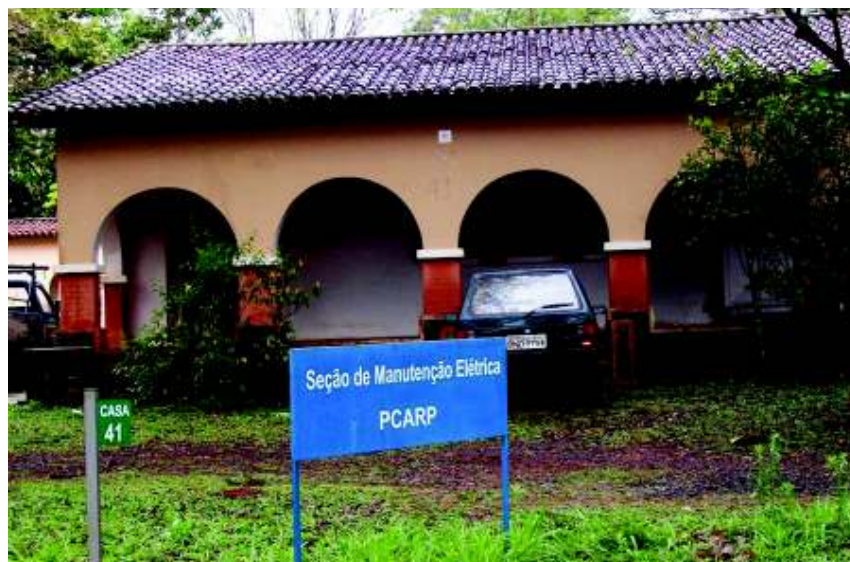
Figura 3 – Seção de Manutenção Elétrica da PUSP-RP, na Rua Clóvis Vieira, casa 41
